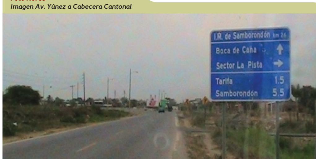
Foto No. 55 Imagen Av. Yúnez a Cabecera Cantonal
