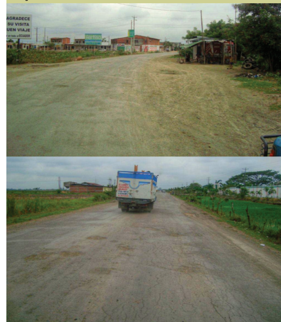
Foto No. 56 Imágenes de vía Samborondón – Puerto la Victoria
