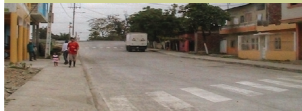
Foto No. 88 Calle Alberto Franco vista al Norte intersección con la calle Samborondón
