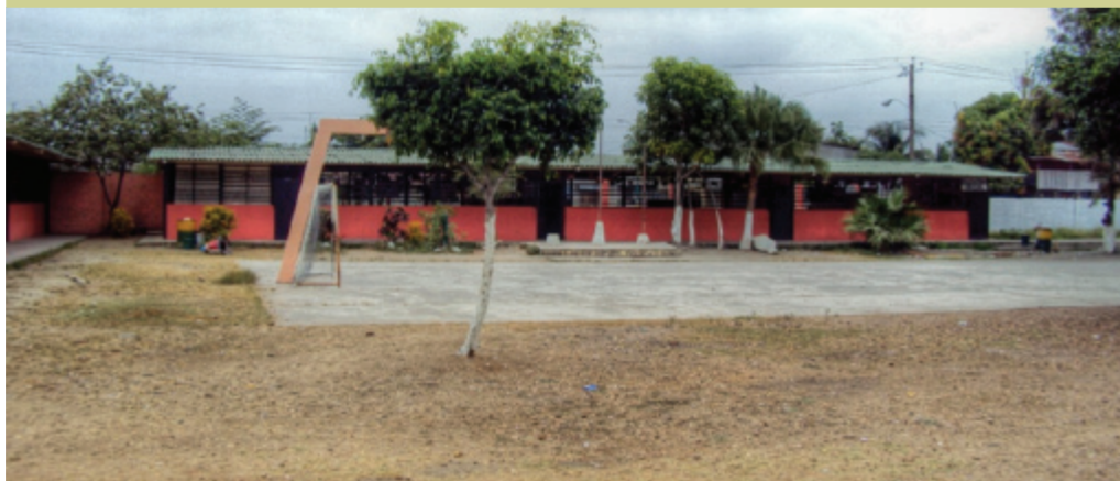
Foto No. 41 Escuela Municipal Eloy Alfaro, Boca de Caña
