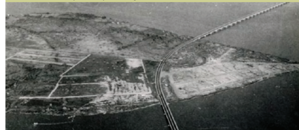
Foto No. 31 Vista de La Puntilla, poco tiempo de inaugurado el Puente
