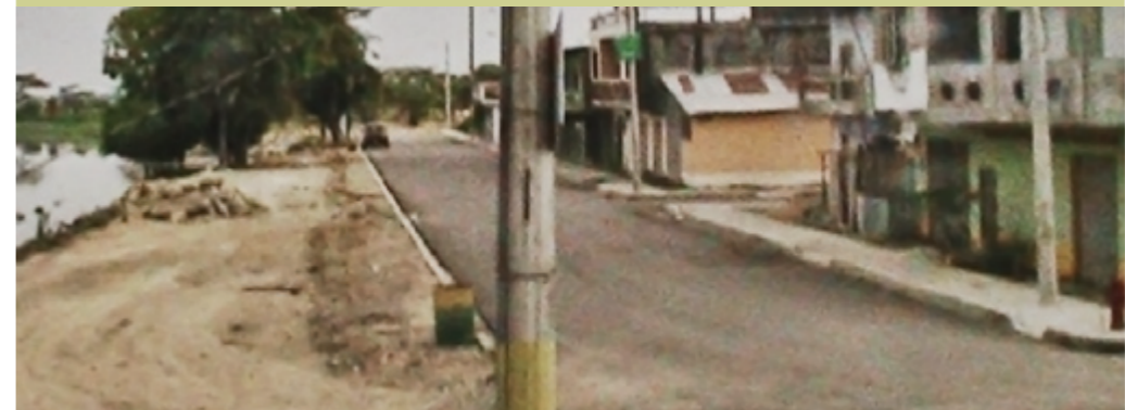
Foto No. 98 Boca de Caña
