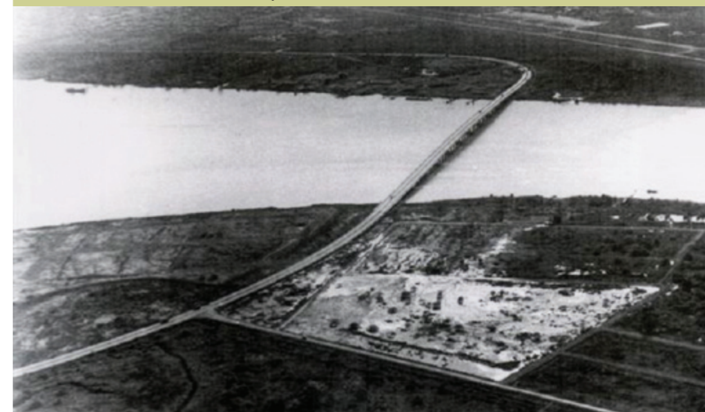
Foto No. 32 Vista de la Construcción de la I Etapa de Entre Ríos
