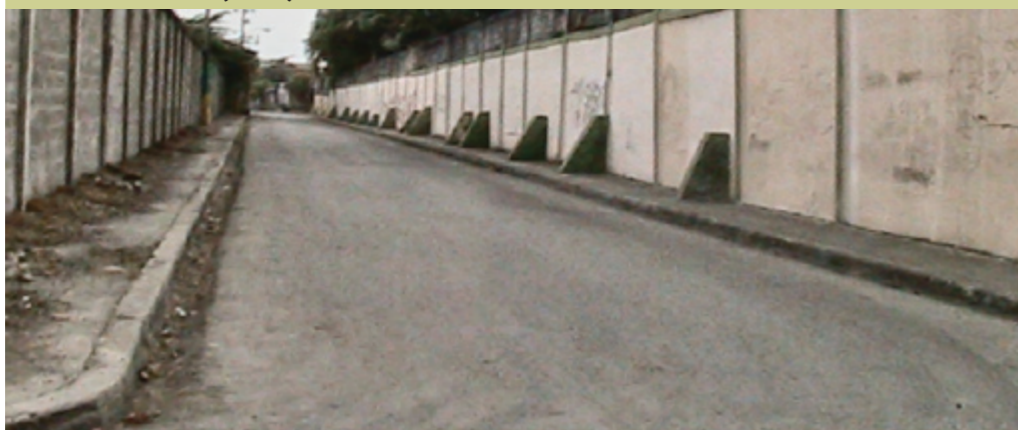
Foto No. 103 Calle 4 de Octubre (Oeste)
