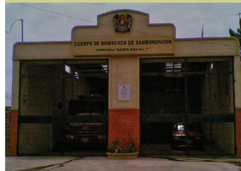
Foto No. 51 Cuartel Bomberos Santa Ana
